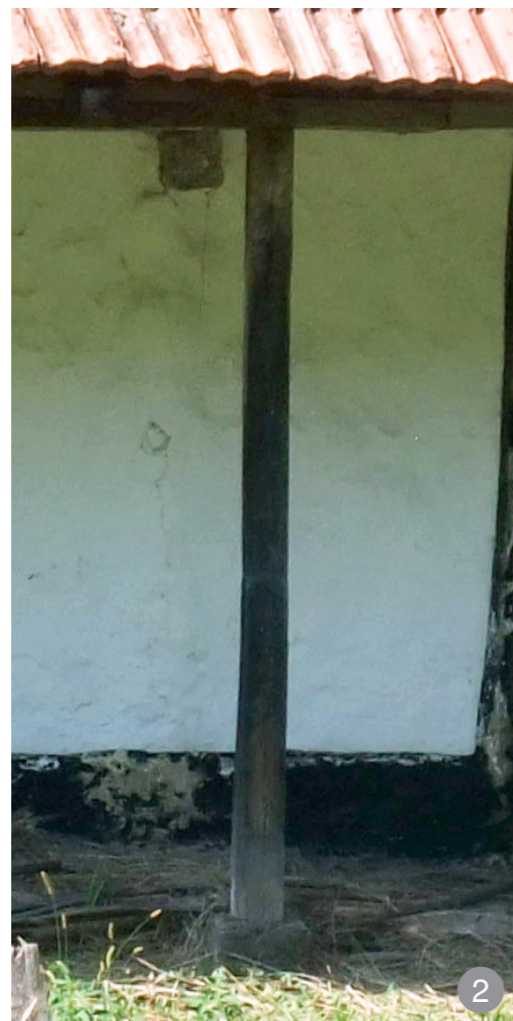
2 Stâlp din lemn așezat pe o talpă punctuală din piatră.
