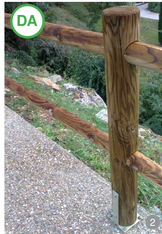
AȘA DA: Soluții puțin industrializate pot asigura rezolvări rapide a lungimilor mari de împrejmuire.
