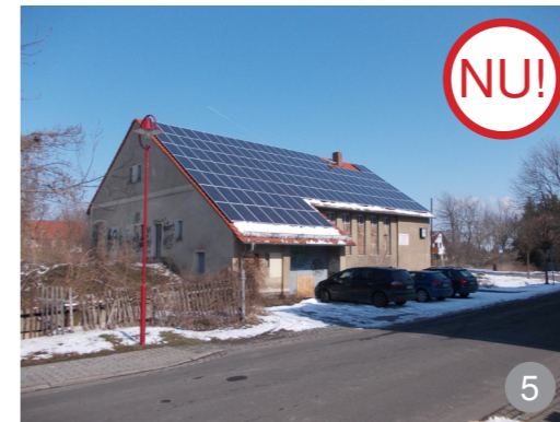
AȘA NU: Acoperirea totală a învelitorii cu panouri fotovoltaice face ca acestea să se substituie ele însele învelitorii și să influențeze într-un mod neplăcut imaginea de ansamblu a clădirii.
