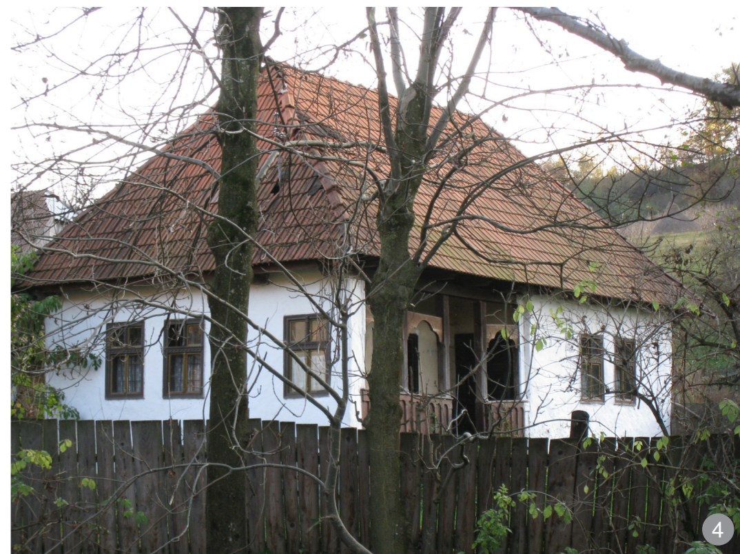
Târnaț din lemn parțial, pe latura lungă, la o casă cu planimetrie în „L” în zona Fildurilor.
