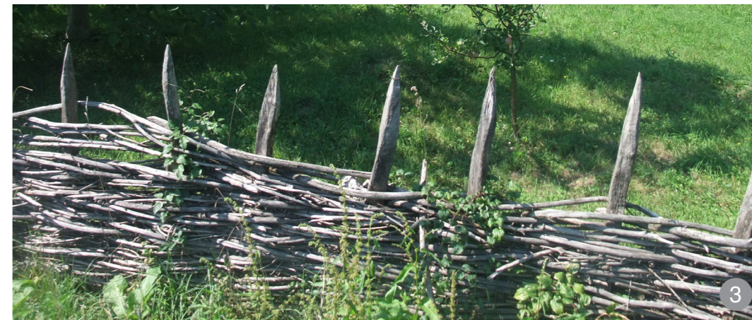
3 Împrejmuire din nuiete de alun împletit între pari crăpați din lemn de salcâm.
