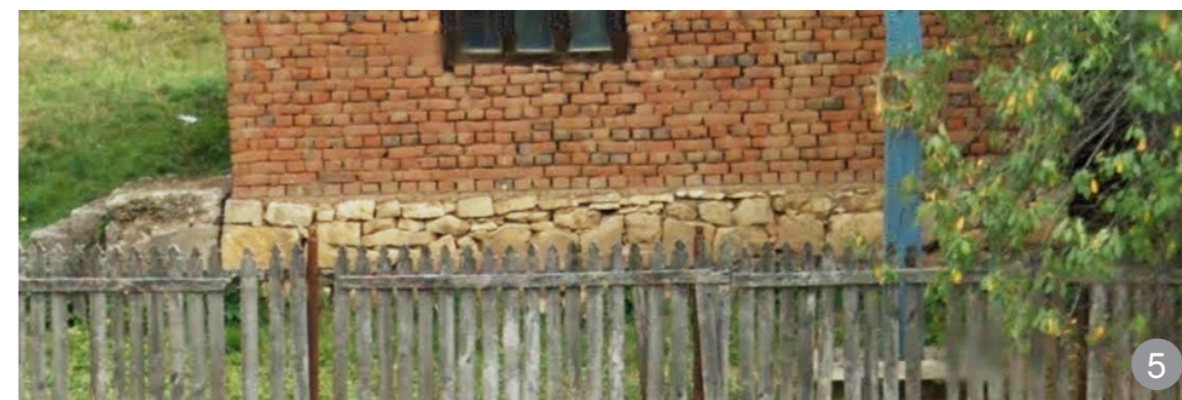
Fundație din lespezi de piatră așezate sub pereții din cărămidă
