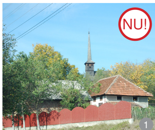
AȘA NU: Se interzice folosirea materialelor din fibră de sticlă, plastic, tip ondulin pentru realizarea împrejuririlor.
