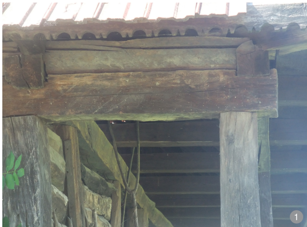
Stâlpii de lemn ai târnațului sprijină cununile pe care reazămă grinzile planșeului.
