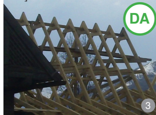
AȘA DA: Șarpantă cu căpriorii sprijiniți pe grinzile planșeului peste parter. Panele de coamă își fac apariția pentru alinierea și contravântuirea acoperișurilor cu funduri drepte.
