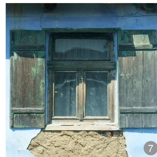
Obloane simple, din scânduri, la ferestrele la stradă, în zonele Zimbor-Sânmihaiu Almașului și Românaș-Romita.
