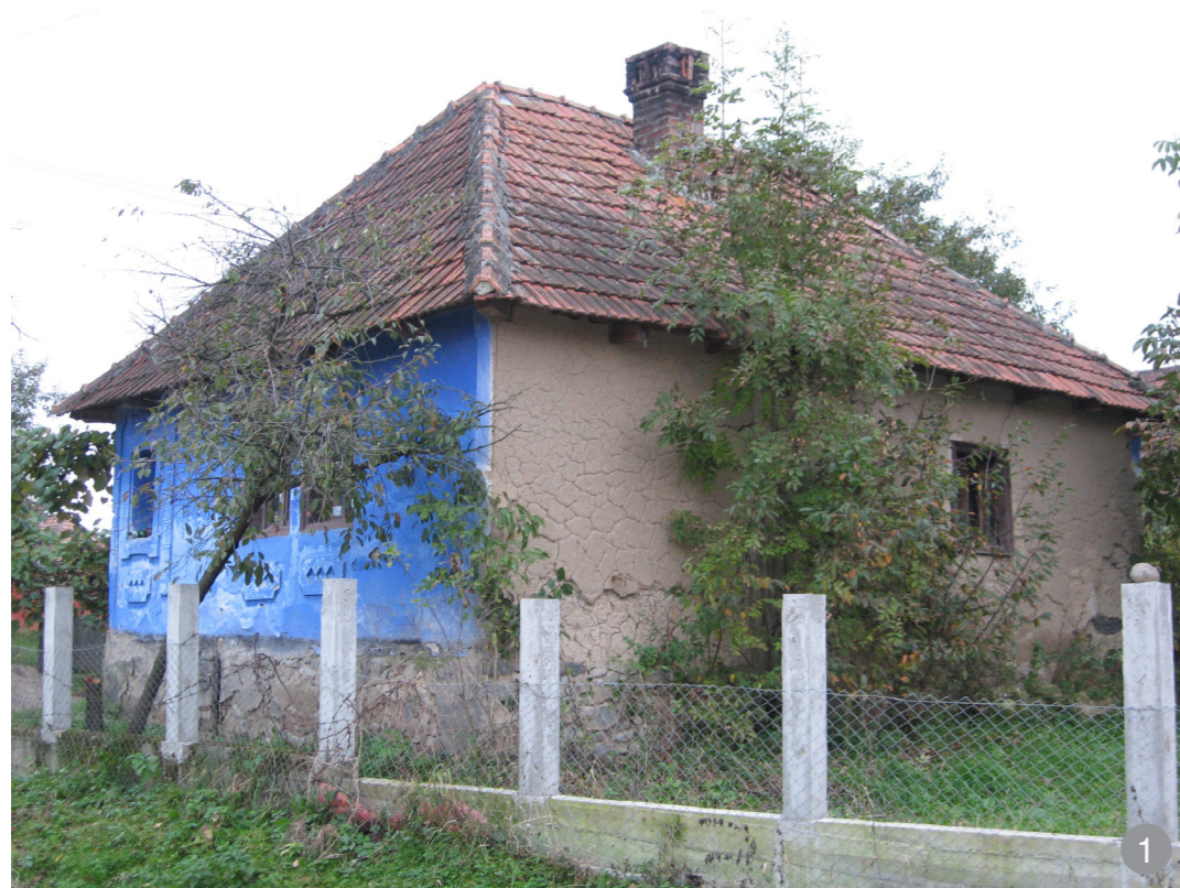
Ierarhia fațadelor la o casă din zona Meseș. Se observă diferența de tratare a fațadei de la stradă față de fațada orientată către vecin prin finisaje și decorații.
