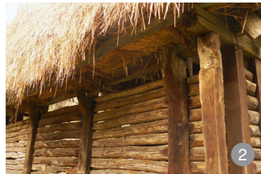
Specificul local la streșinile acoperișurilor din paie la șura din satul Țăudu, aflat acum în Complexul Național Muzeal „ASTRA”, Sibiu
