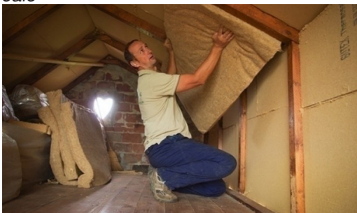
Montarea termoizolației din fibre de cânepă
