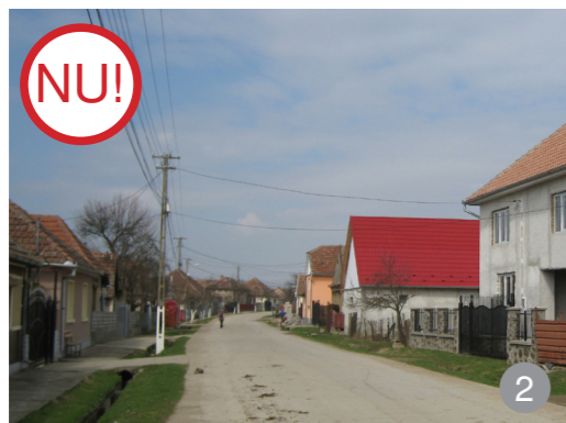
AȘA NU: Culoarea învelitorilor industriale este prea stridentă prin comparație cu coloritul pământiu al învelitorilor tradiționale.
