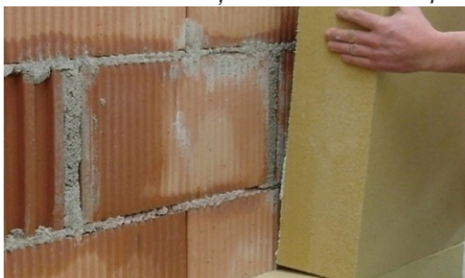
Montarea termoizolației din fibre de lemn
