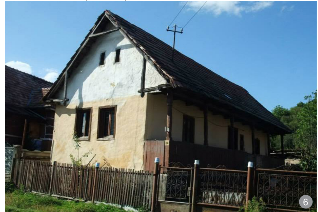
Târnaț din lemn pe o latură, balustradă din scânduri cu șoși de lemn galbați cu bază și capitel.
