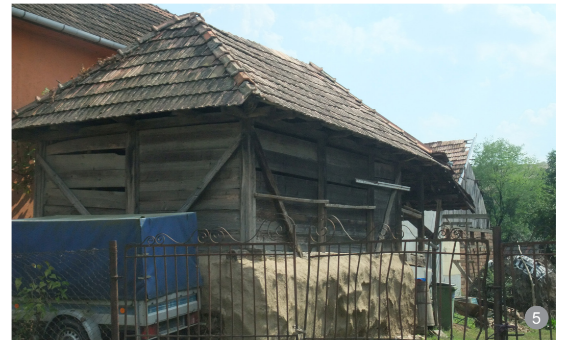
Anexă găbănaș din lemn peste pivniță din piatră lipită.
