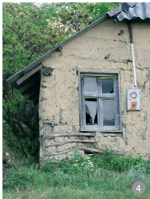
Perete cu pământ lipit între lobde (lețuri)
