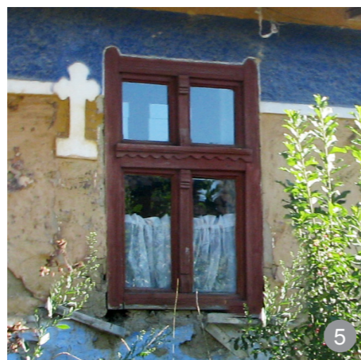
Fereastră dublă, fiecare față având două canaturi, cu transversa și montantul decorat.
