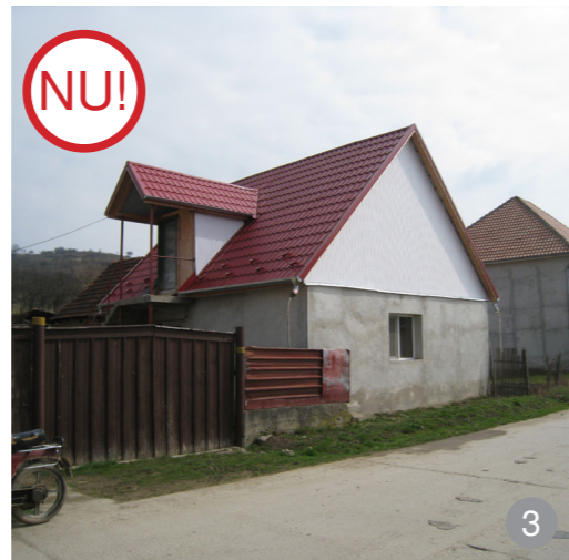
AȘA NU: Folosirea tablei ridică o gamă largă de întrebări, plecând de la problema reciclării ei până la probleme de onestitate: imitarea prin culoare și formă a țiglei ceramice. Cele mai mari probleme rămân însă cele legate de aspect, de încălzire excesivă, care poate crea un disconfort vara într-o mansardă locuită și de zgomot pe timp de ploaie sau grindină. În cele din urmă, tabla este un material ieftin, importat din zona construcțiilor industriale, unde până de curând nu a contat aspectul finisajului. Prezentul ghid interzice folosirea tablei pe suprafețe mai mari de 15% din suprafața unui acoperiș.
