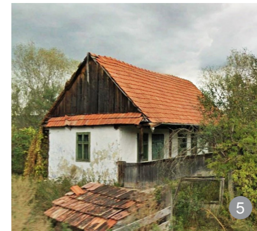
Locuință care folosește detalii de acoperiș cu aruncător în satul Sfăraș
