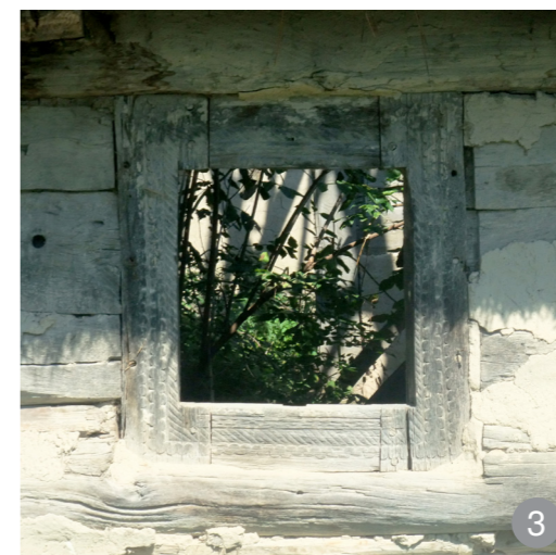
Lăcaș decorat cu incizii în „unghii”, în pereți din grinzi de lemn, pentru fereastră simplă din lemn.
