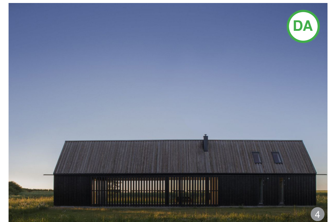
AȘA DA: Pereții vitrați pot fi dublați de un element de umbrire din lemn care trimite la detaliile de închidere ale construcțiilor tradiționale.
