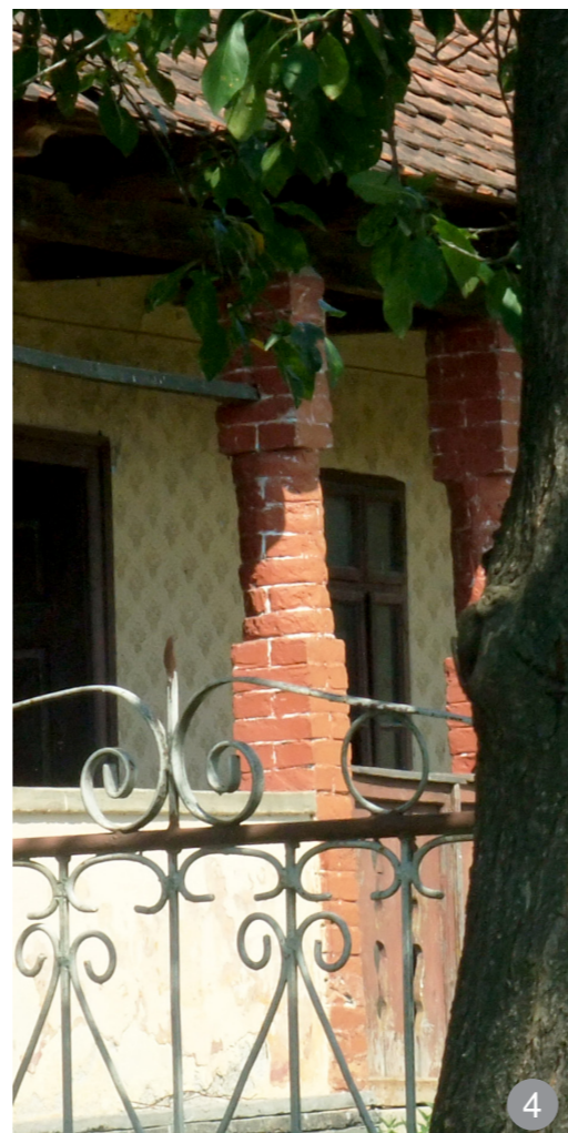
4 Stâlpi din cărămidă aparentă cu secțiune compusă – pătrată și parțial circulară.
