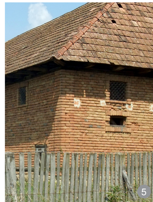
Perete din zidărie de cărămidă arsă
