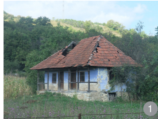
Acoperiș specific în patru ape
