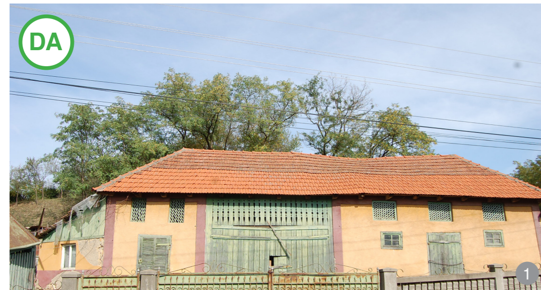
AȘA DA: Completarea țiglei deteriorate cu țiglă nouă.
