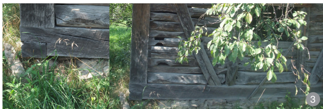
Fundație din piatră mare spartă prinsă cu mortare pe bază de pământ
