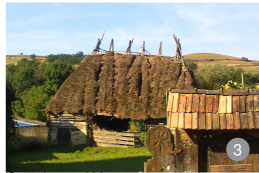
Șură din satul Mesteacănu – înălțimea acoperișului din paie este de două ori mai mare decât cea a pereților.
