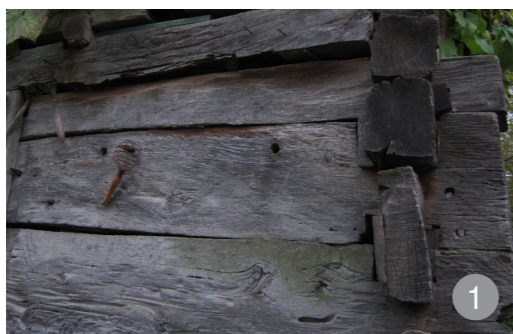
Șură cu perete din lemn realizat cu cheutorilor drepte.
