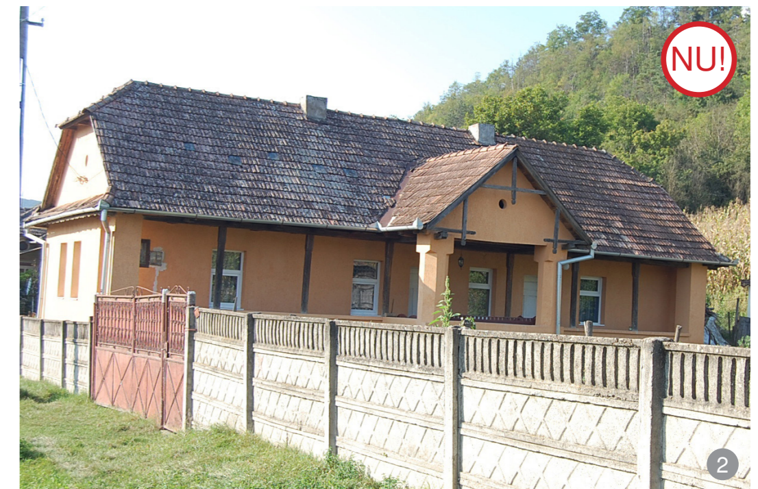
AȘA NU: În reabilitarea unei construcții tradiționale sunt interzise: tencuirea și acoperirea detaliilor prin termoizolare, folosirea unei culori nespecifice și înlocuirea ferestrelor tradiționale cu ferestre de tip termopan care nu respectă canaturile ferestrelor inițiale.
